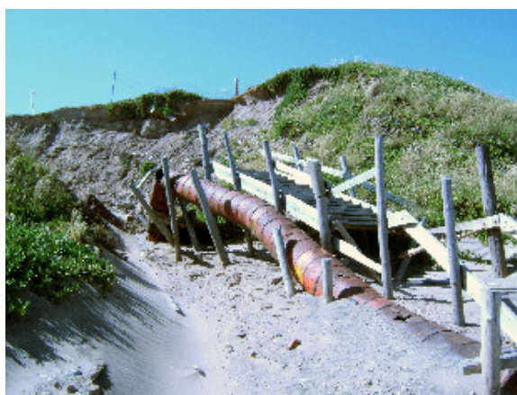
Figura. 5: Ducto aguas de escorrentía
